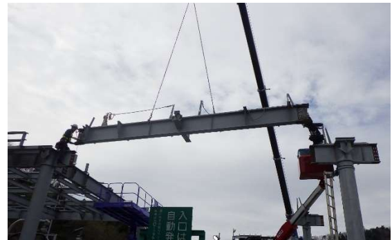
大梁建入作業状況
