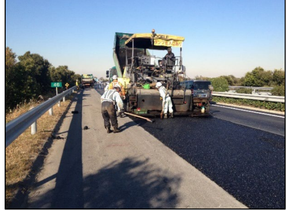
舗装補修工事 作業状況写真
