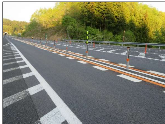
舗装補修後イメージ
