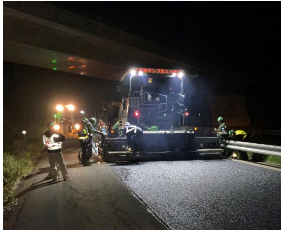
路面補修工事例
