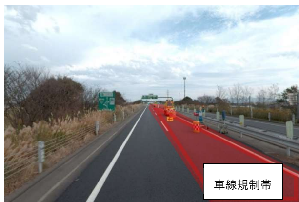
片側2車線道路の場合 ⇒車線規制での工事を実施
