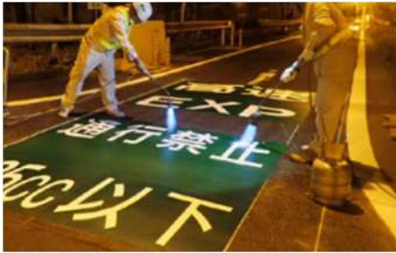
逆走対策工事 作業状況
