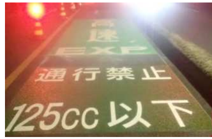
逆走対策工事 完成状況
