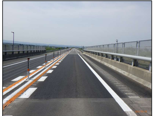
舗装補修後イメージ
