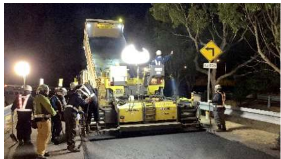
舗装補修工事 作業状況
