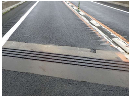
伸縮装置写真
