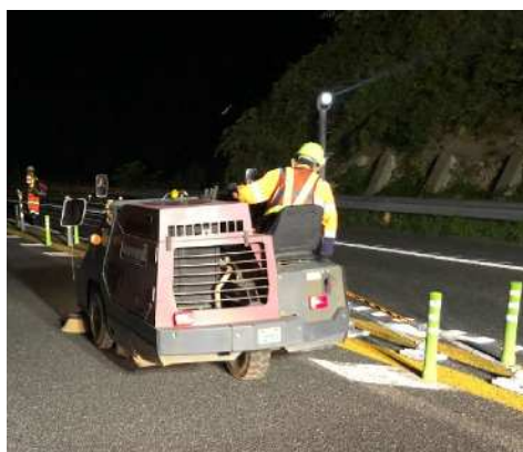
道路保全工事
