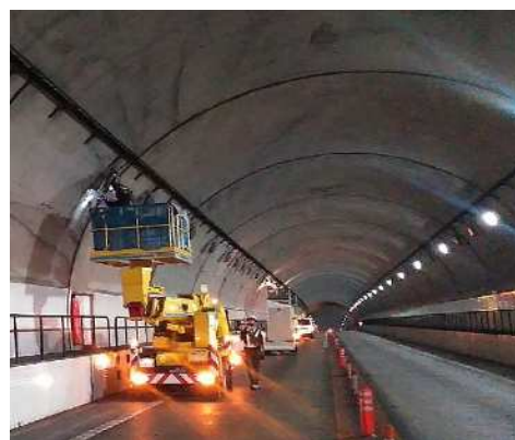
道路構造物点検作業状況
