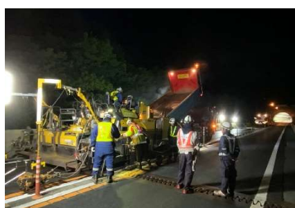
舗装補修工事 作業状況写真
