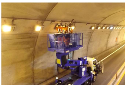
トンネル内設備補修状況写真
