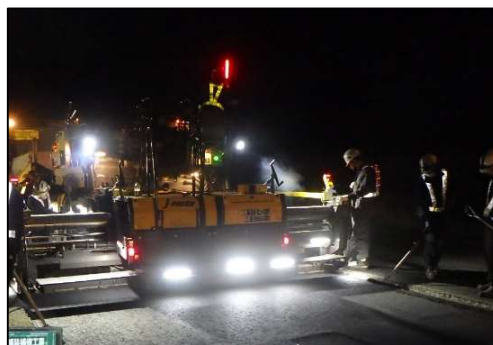
舗装補修工事 作業状況写真
