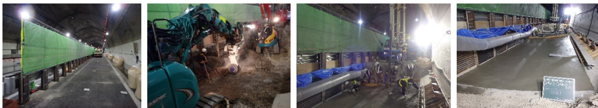
防護柵設置状況
