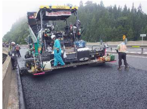
舗装補修工事 作業状況写真
