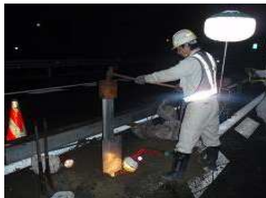
事故復旧工事 作業状況
