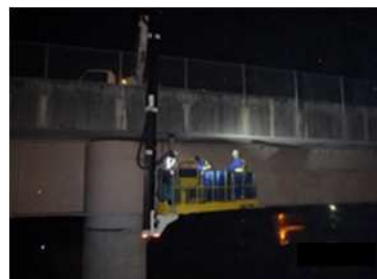
道路構造物点検 作業状況
