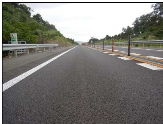
舗装補修後イメージ
