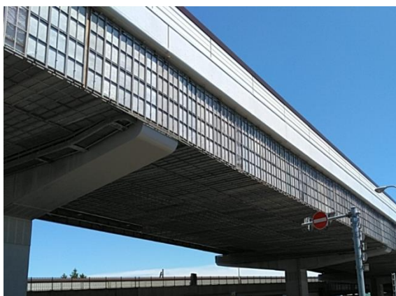
撤去する足場
