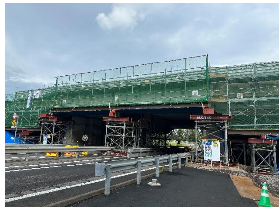
撤去する支保工
