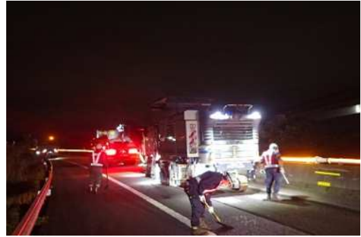
舗装補修工事 作業状況
