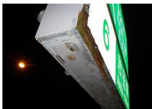
標識板劣化状況
