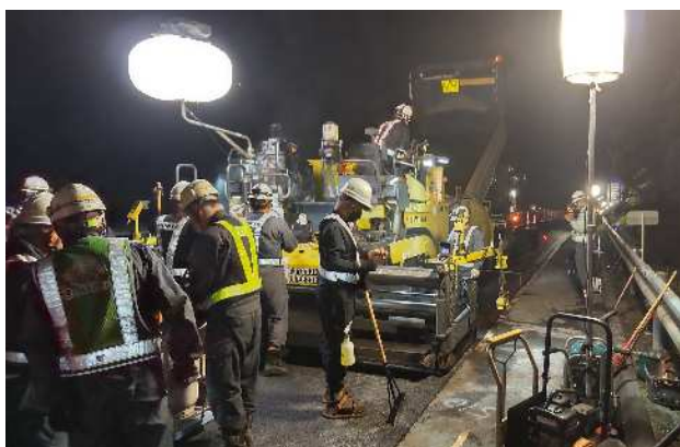
舗装補修工事
