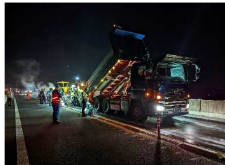
舗装補修工事 作業状況
