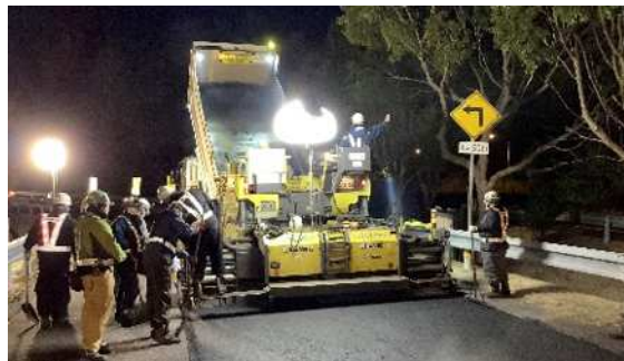
舗装補修工事 作業状況
