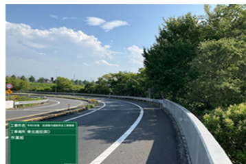
加須IC 出口ランプ 植栽現況
