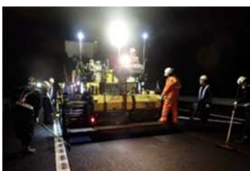
舗装補修工事 作業イメージ図
