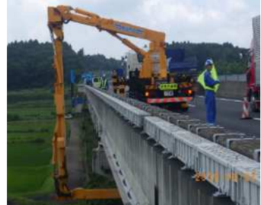
橋梁点検 作業状況
