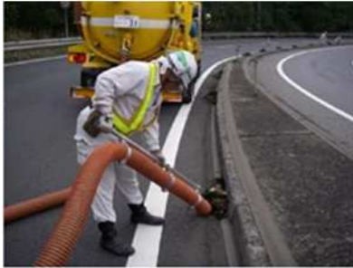
路面清掃作業 作業状況
