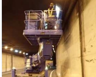
トンネル内設備 点検状況
