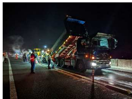
舗装補修工事 作業状況
