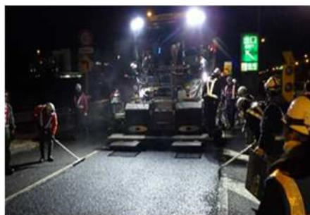
舗装補修工事 作業イメージ図
