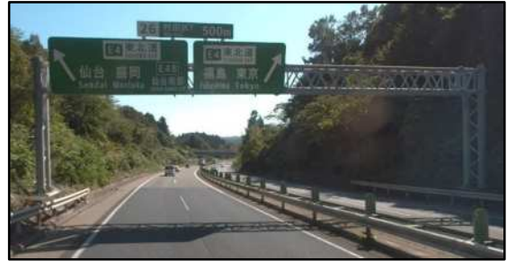
門型標識柱設置後(イメージ)
