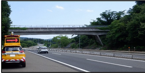
門型標識柱設置前
