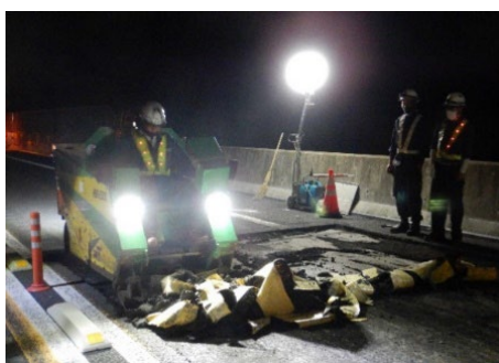
舗装補修工事 作業状況
