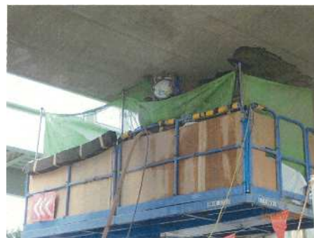
はく落対策作業状況 イメージ
