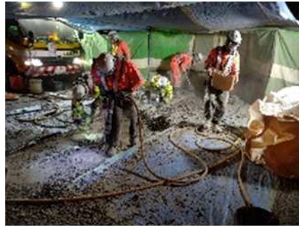
伸縮装置 取替工事
