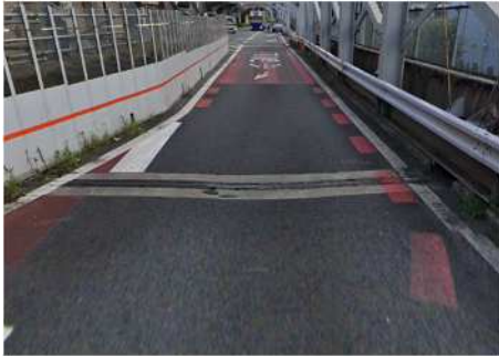
伸縮装置 現況
