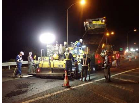
舗装補修工事 作業状況
