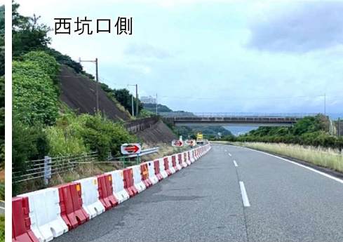
昼夜連続車線規制の状況
