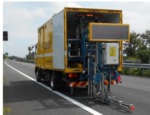
事前調査作業状況
