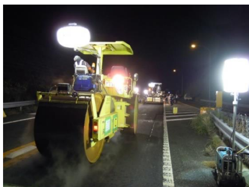
舗装補修工事
