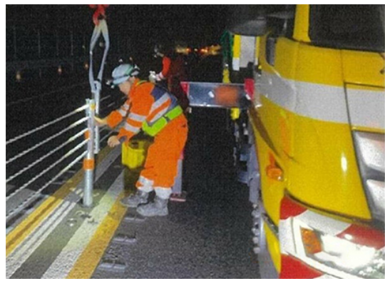
道路構造物補修 作業状況
