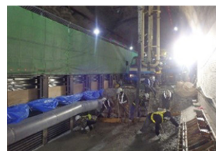
コンクリート打設状況
