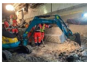
インバート掘削状況
