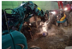
インバート掘削状況
