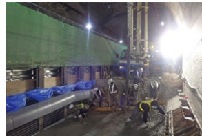
コンクリート打設状況
