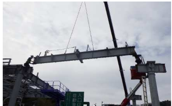
大梁建入作業状況
