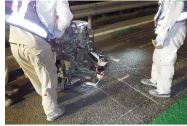
逆走対策工事 作業状況
