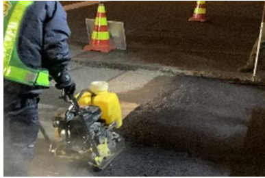
舗装補修工事 作業状況
