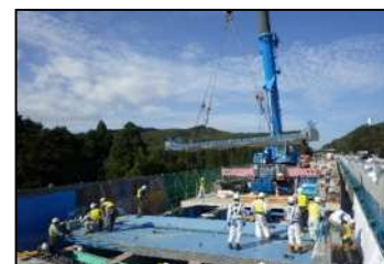
【新しい床版設置状況】
