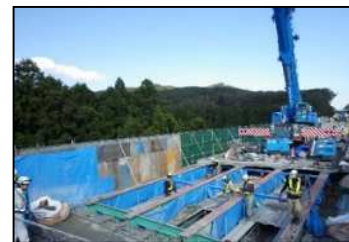
【古い床版撤去状況】
