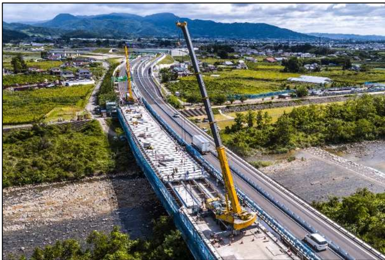
【対面通行規制状況】
