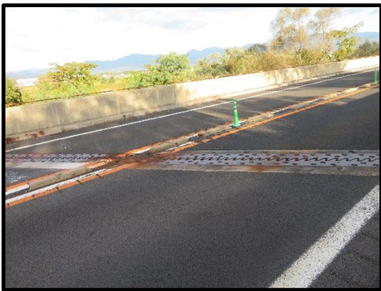
区画柵設置前
