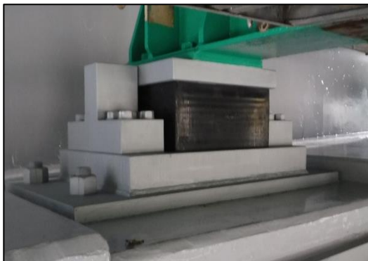
支承取替後状況(イメージ)
