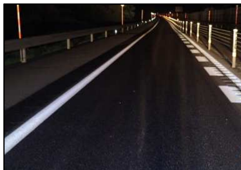
舗装補修後イメージ
