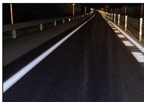
舗装補修後イメージ
