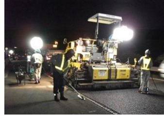
舗装補修工事 作業状況
