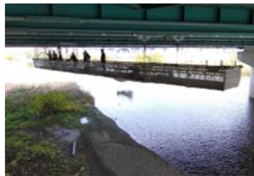
移動式吊足場を活用した点検の実施状況
