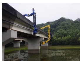
橋梁点検車の活用
