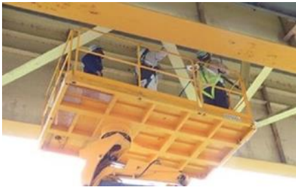
狭隘部の例 (横桁上フランジと床版の間)
