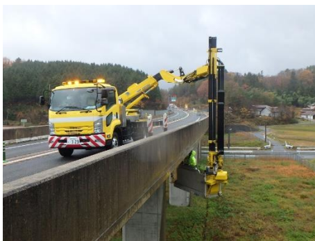
橋梁点検車を活用した点検の実施状況
