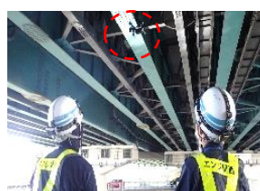
ドローンの飛行状況(遠景)
