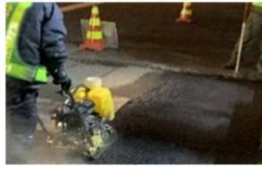
舗装補修工事 作業状況
