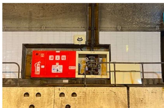
非常用設備更新
