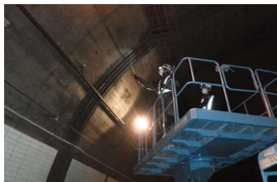
トンネル内設備の点検状況
