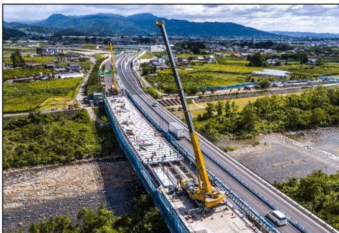
【対面通行規制状況】
