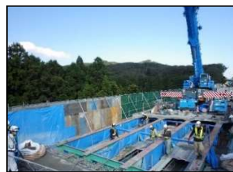
【古い床版撤去状況】
