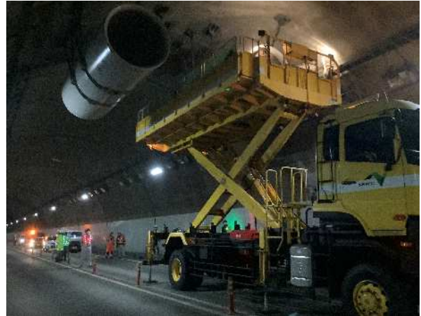
トンネル点検
