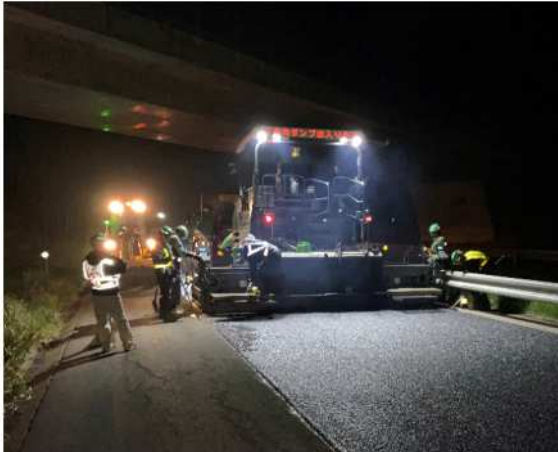
路面補修工事例
